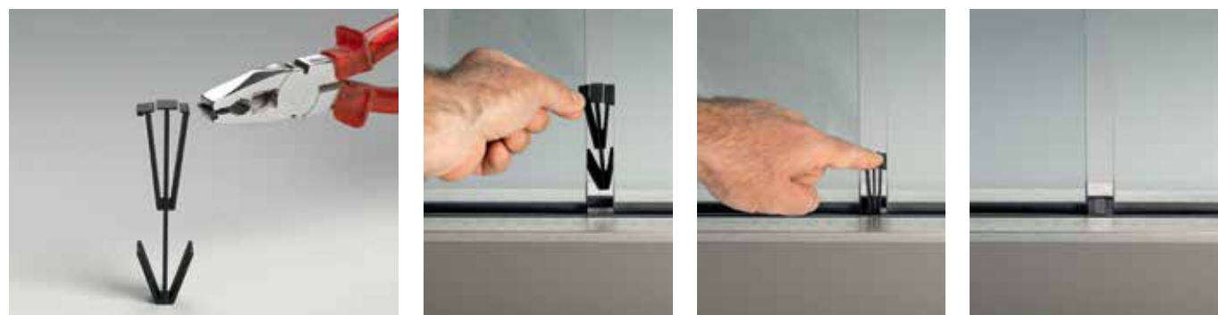
8. De voegen tussen de glaselementen opvullen met de aanpasbare glasspacer
