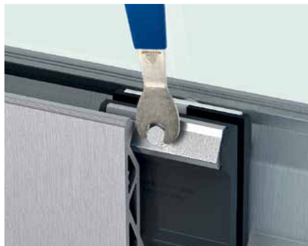
5. Aanschroeven van klemmen door het handmatig aandraaien van de bouten.
